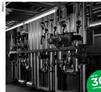
Управление насосной станцией
